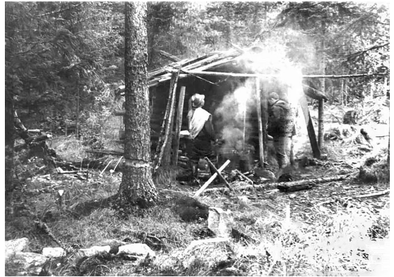
Просушка и ремонт таёжной избушки в Клочках
